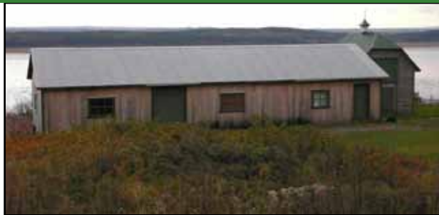
Restauration ou rénovation d'un bâtiment secondaire. La saline de Pierre Fraser
