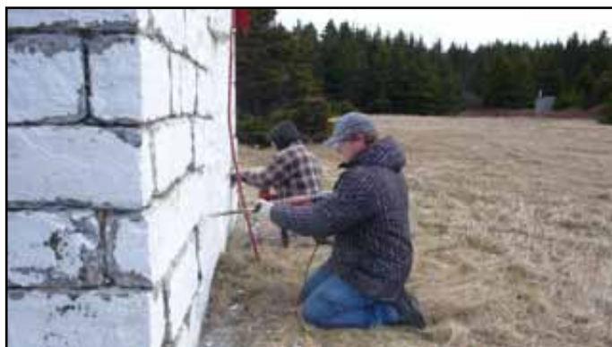
Maçons à l'oeuvre
